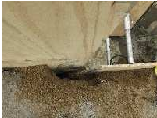
(d) Sand are used to fill exterior gap
